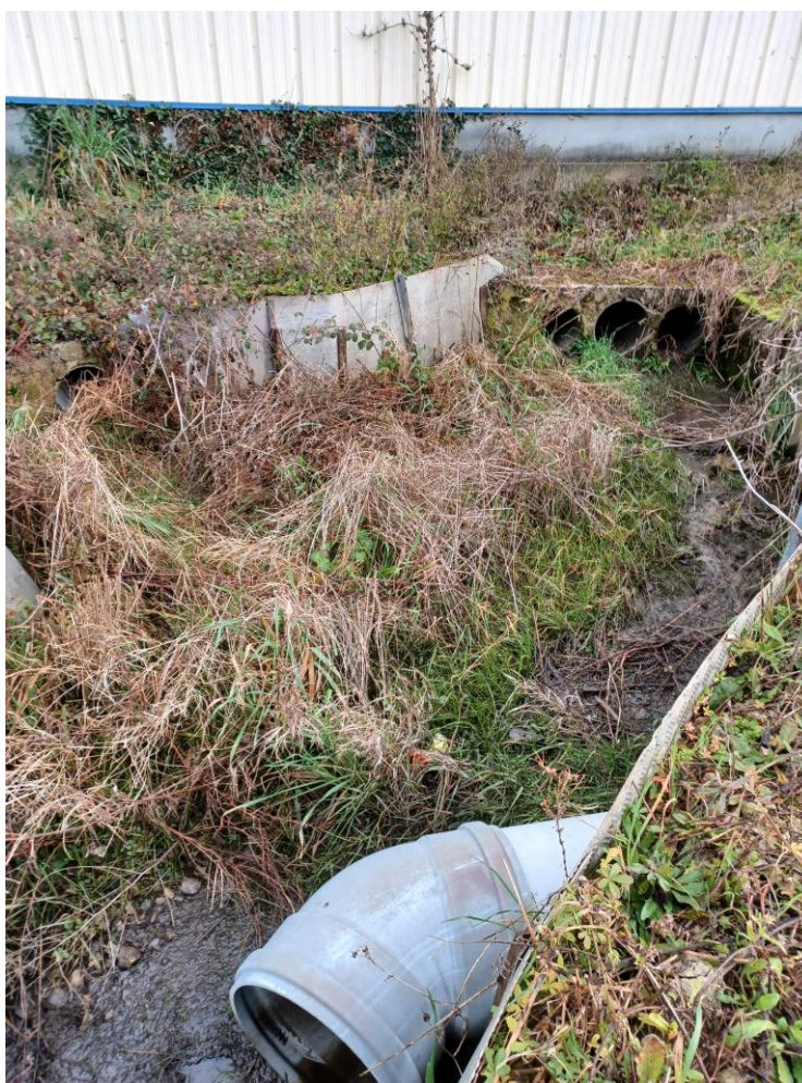
Photo des buses passant sous le bâtiment de la casse auto
